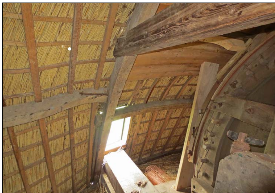
Figuur 19: Plaatsing van rinkelatten op een molenkap voor de bevestiging van het riet. Door dunne latten te gebruiken kunnen die meegebogen worden in de vorm van de molenkap.
